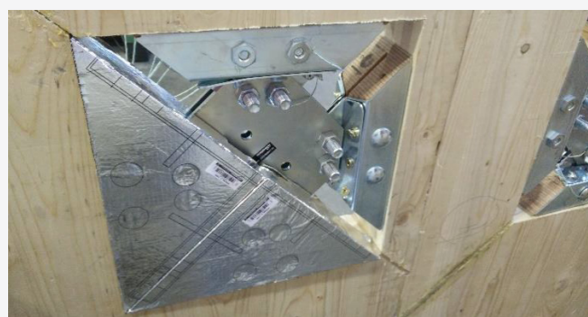
Montaje de los componentes X-SEAL
