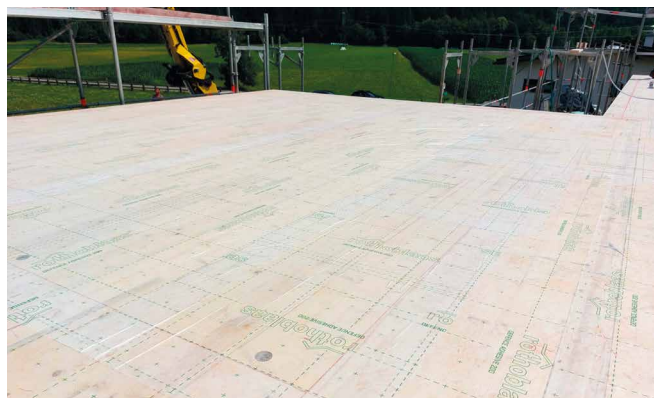
Sprječavanje klizanja i zaštita panelā
