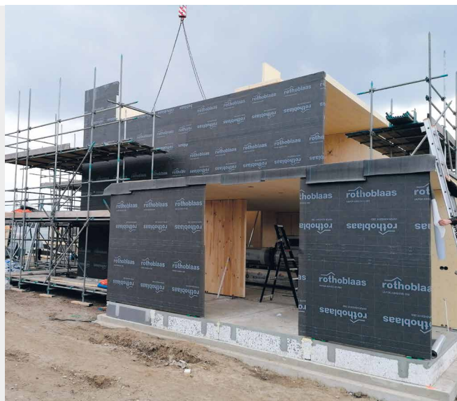
Sprječavanje klizanja i zaštita panelā
