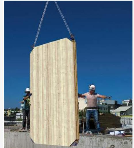
En función del peso del panel CLT y del ángulo comprendido entre los dos cables de elevación ( $\beta$ ), se puede obtener la fuerza solicitada en cada punto de enganche (**T**). Aplicando los oportunos coeficientes de seguridad, se pueden comparar el esfuerzo solicitado en el punto de elevación con la resistencia del X-ONE.
